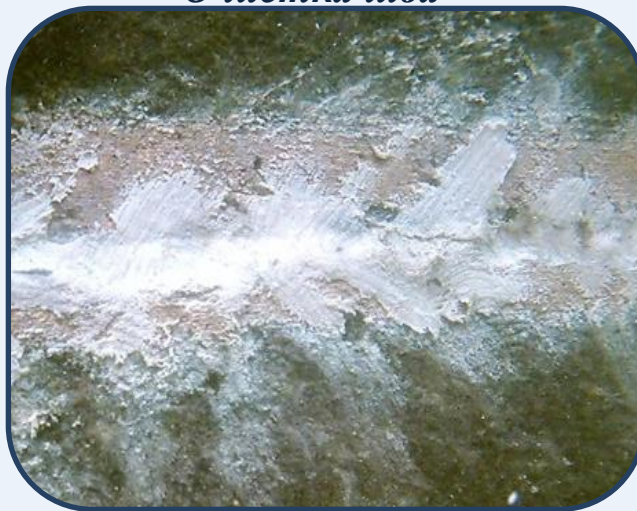
Состояние шва после герметизации ПК «Коутекс»
