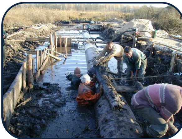
восстановление и ремонт на суше
