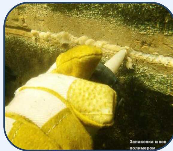
Запакровка шва ПК «Коутекс ПР-спрут»
