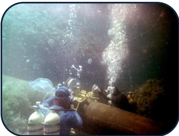
восстановление и ремонт под водой
