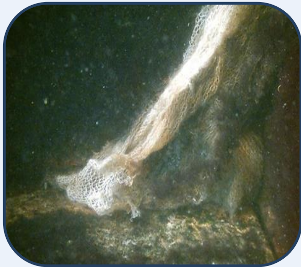
Состояние шва до герметизации ПК «Коутекс»
