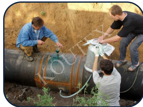
бандажирование, ремонт локальных участков
